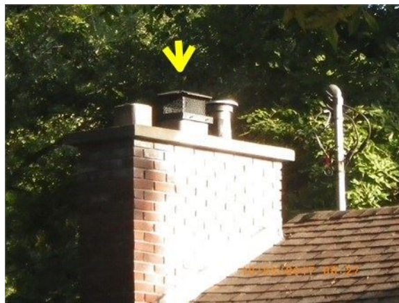
Ex: de la cheminée de maçonnerie
