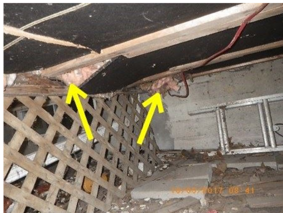
Ex: d'ouvertures sous la véranda où la vermine peut s'infiltrer à l'intérieur de la maison
