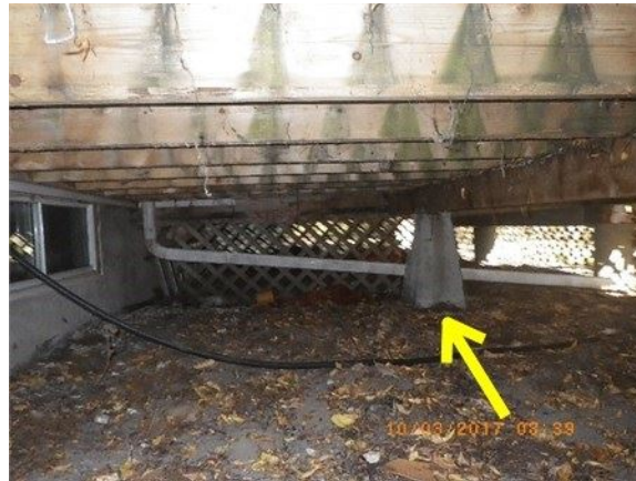
Ex: d'un des supports de la terrasse qui sont déposés sur des tuiles de béton sur le sol
