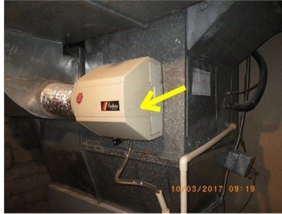
Ex: de l'humidificateur en place sur la fournaise
