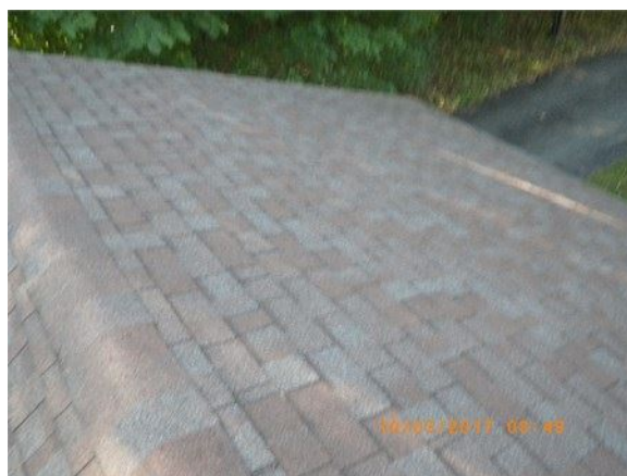
Ex: du revêtement de bardeaux d'asphalte de la toiture
