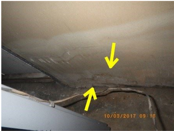
Ex: des traces d'eau visible au sous-sol dans la chambre à fournaise
