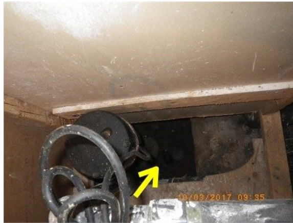
Ex: du puisard en terre
