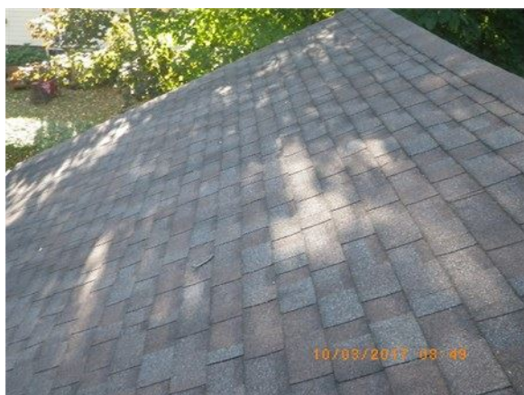
Ex: du revêtement de bardeaux d'asphalte de la toiture
