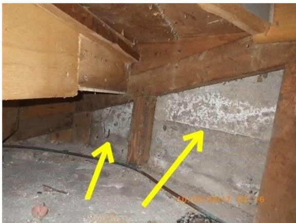
Ex: des cernes d'efflorescences visible au sous-sol lors de l'inspection
