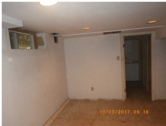
Ex: du sous-sol aménager de la maison
