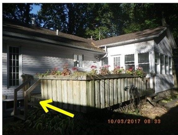
Ex: des rampes d'escalier sans barreaux pour la sécurité
