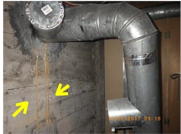
Ex: des traces d'eau visible au sous-sol dans la chambre à fournaise
