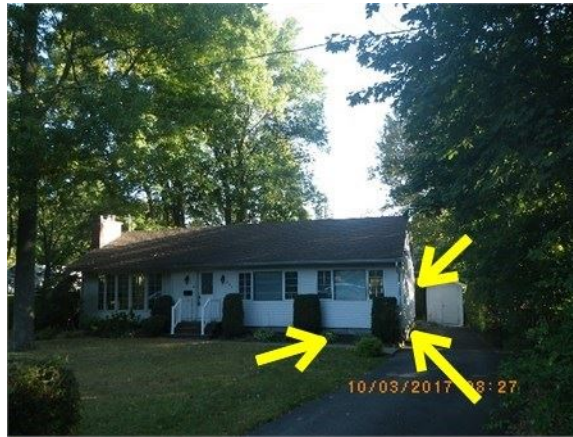
Ex: de la partie de la chambre où ont n'a pas d'accès en dessous pour inspecter
