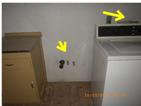
Ex: des conduites d'eau dans le mur extérieur de la salle de lavage
