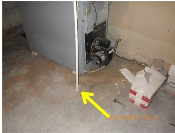
Ex: du conduit d'évacuation de la condensation de l'air climatisé qui est évacué sous la dalle de béton
