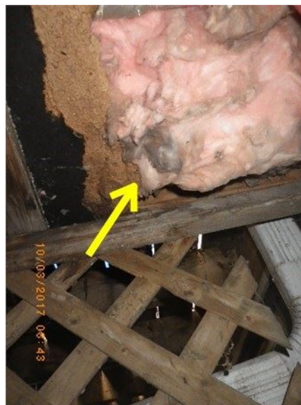
Ex: d'ouvertures sous la véranda où la vermine peut s'infiltrer à l'intérieur de la maison
